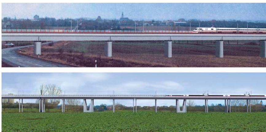
Fig.1. Deutsche Bahn’s reference design for Gaensebachtal viaduct; Schlaich Bergermann und Partner’s design concept for the same.
