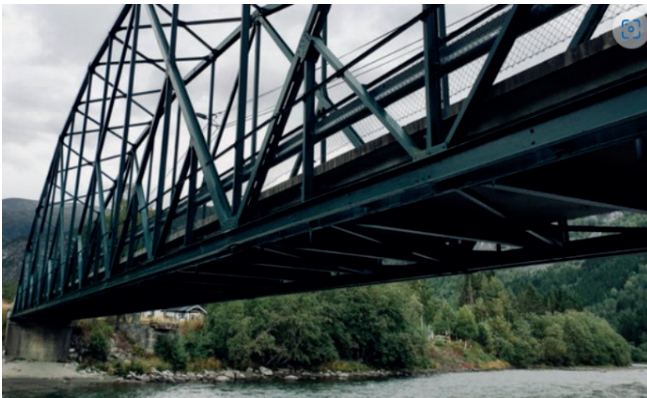
Nisja truss bridge in Sunndal kommune, Møre og Romsdal in Norway
